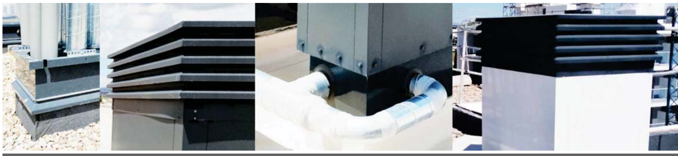
■ EJEMPLO 23_Encuentro con pretil con estructura interior de soporte cubierta transitable apoyado en forjado de losa alveolar
